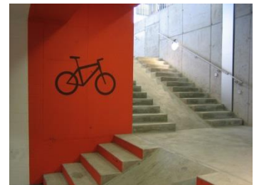
Unterführung zwischen der Velostation und den Geleisen
