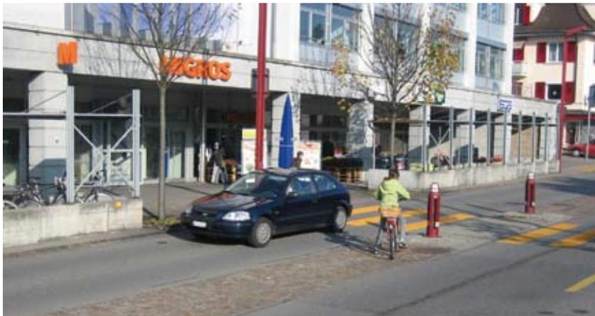
La présence d'un îlot permet aux cyclistes de se mettre en ordre de présélection et de traverser la chaussée en deux temps. À noter aussi la bordure de trottoir aménagée sous forme de rigole (Bernstrasse, Zollikofen, BE).
