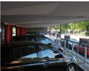
Tageslicht führt zu einer angenehmen Raumatmosphäre (Parkhaus Sihlquai Zürich).
