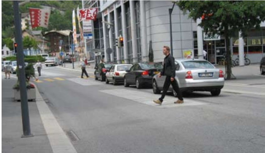
Dank einer Verschmälerung der Fahrbahn bleibt dem Fussverkehr entlang den Geschäften mehr Platz. Der Fahrverkehr läuft auch mit einer starken Belastung von rund 20'000 Fahrzeugen flüssig (Visp VS).
