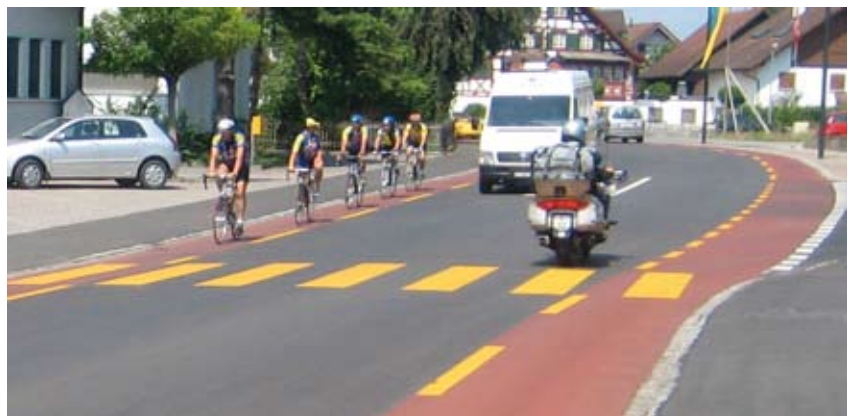
Zum Schutze des Veloverkehrs wurde eine Kernfahrbahn eingerichtet (Oberriet SG).
