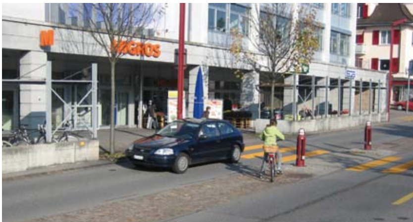
Im Schutze einer Insel kann der Veloverkehr einspuren und die Fahrbahn in zwei Etappen überqueren. Zu beachten ist zudem die als Rinne ausgestaltete Trottoirkante (Bernstrasse in Zollikofen BE).
