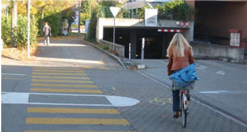
Gesicherte Querung für den Fuss- und Veloverkehr bei der Einfahrt zur Tiefgarage (Einkaufszentrum Ziegelei in Zollikofen BE).
