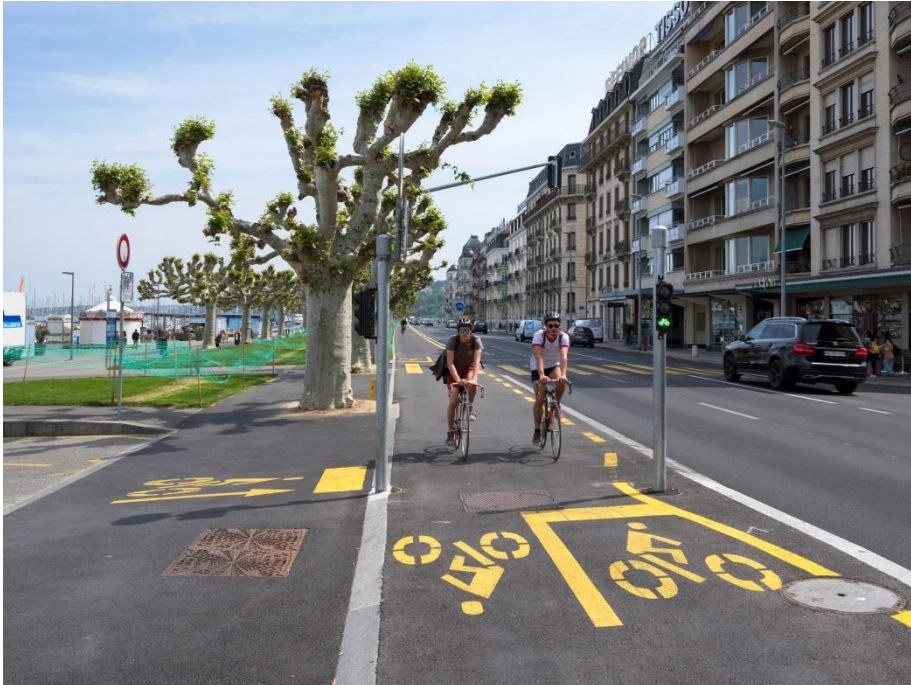
Piste cyclable bidirectionnelle séparée de la chaussée sur le quai Gustave-Ador (© Ville de Genève, Nicole Zermatten)
