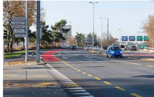
Neue Radstreifen Murtenstrasse - Schlüsselement zweistreifige Schmalfahrbahn MIV
